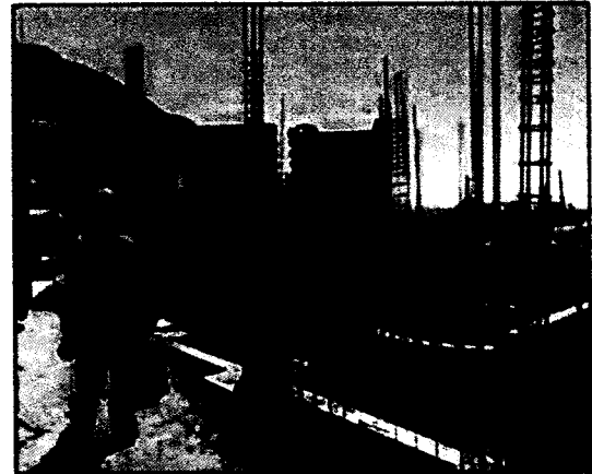
Imagen 8 y 9. Acero en columnas en zona de talleres.
